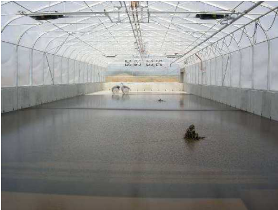
[Fa. Thermo-System Industrie - & Trocknungstechnik GmbH]
